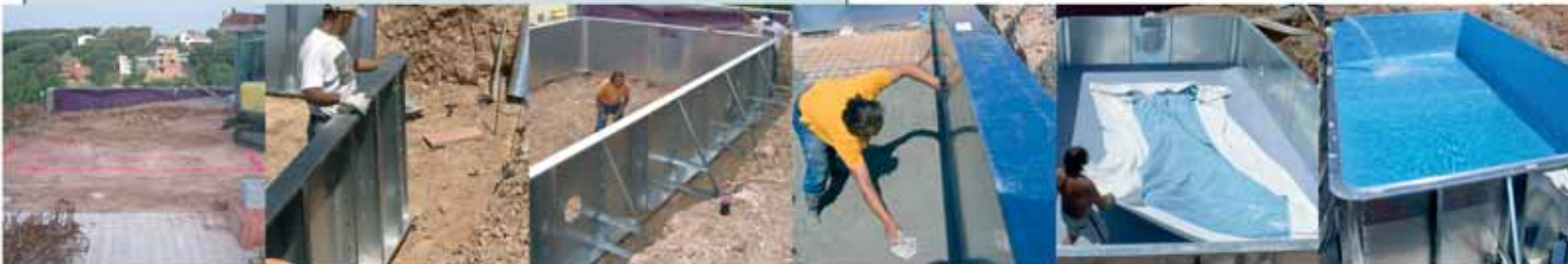
Secuencia de montaje de una piscina de PANELES de acero IDEAL
