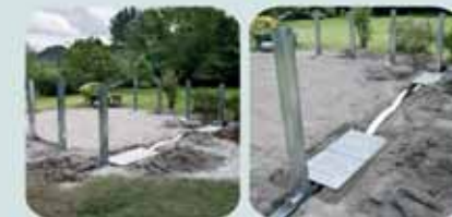
Sistema de OMEGAS En Piscinas Ovaladas
