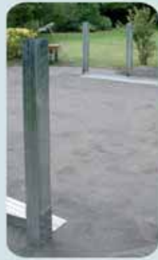
Sistema de OMEGAS En Piscinas Ovaladas
